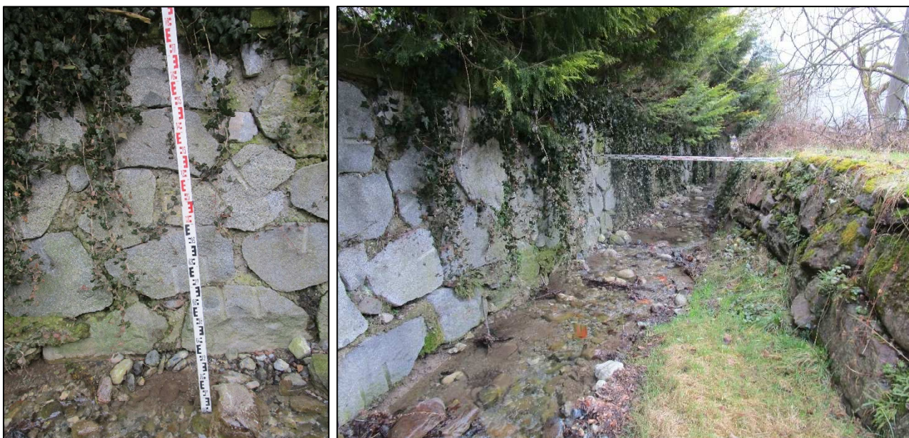
Fig. 24: Esempio di rilievo geometrico dell'alveo della Valle Corna Marsa.
